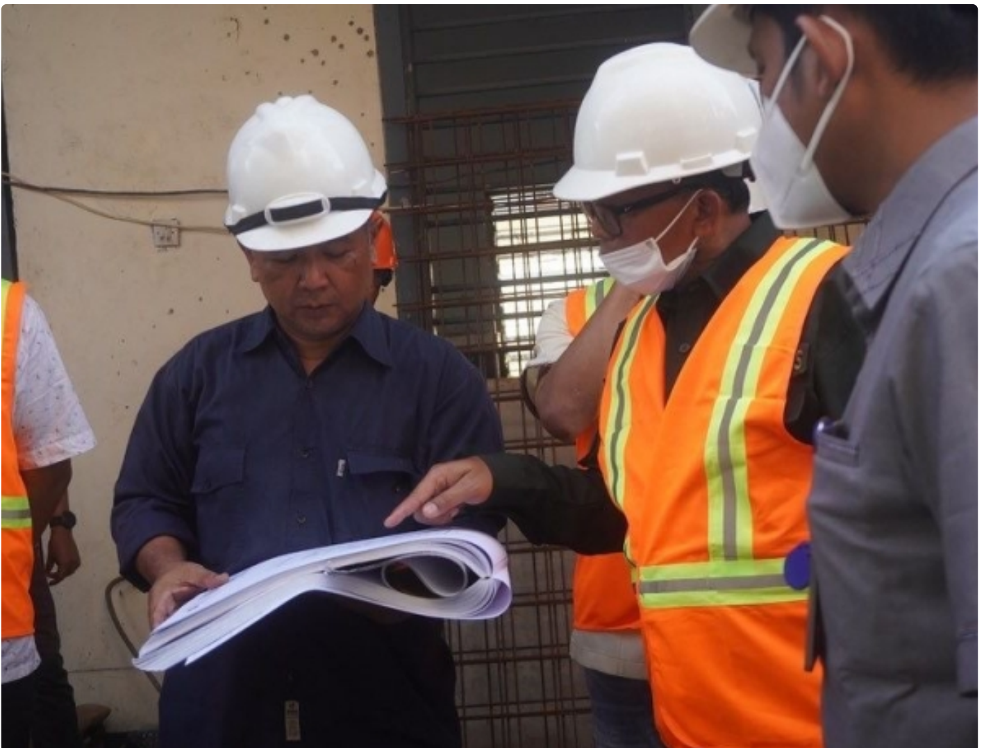
Sesditjen Pemasyarakatan Pantau Progres Pembangunan Rutan Kelas I Semarang
